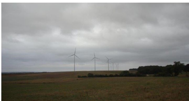
Vue d'ensemble du parc éolien de La Tâche (16)
